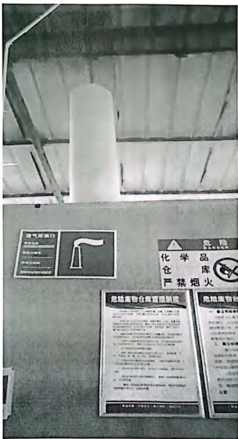
附图2 危废暂存间总排口
