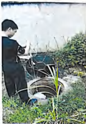
厂区污水排口 W1
